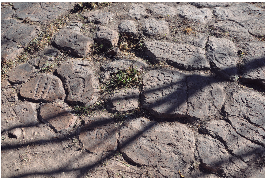
31. Cuadrante suroeste: vista parcial desde el oeste. Foto: Marie-Areti Hers.
