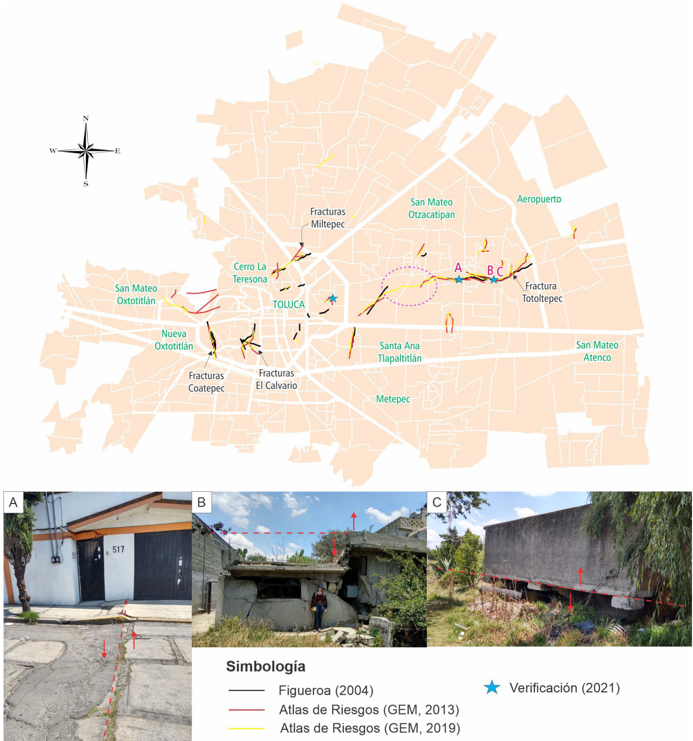
Figura 3 Distribución de fracturas observadas por Figueroa (2004), GEM (2013) y GEM (2019) en el área metropolitana de la ciudad de Toluca. Se muestran fotografías de evidencia de movimientos diferenciales: A) Desplazamiento vertical, B) Fractura de casa-habitación por desplazamiento vertical y horizontal, C) Zapatas de casa-habitación expuestas por subsidencia.
