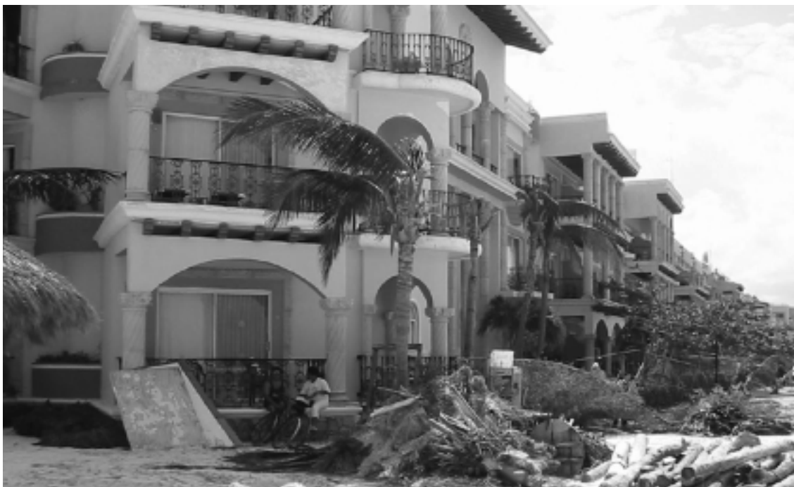
Figura 10. Escombros generados por el viento de Emily en Playa del Carmen.
