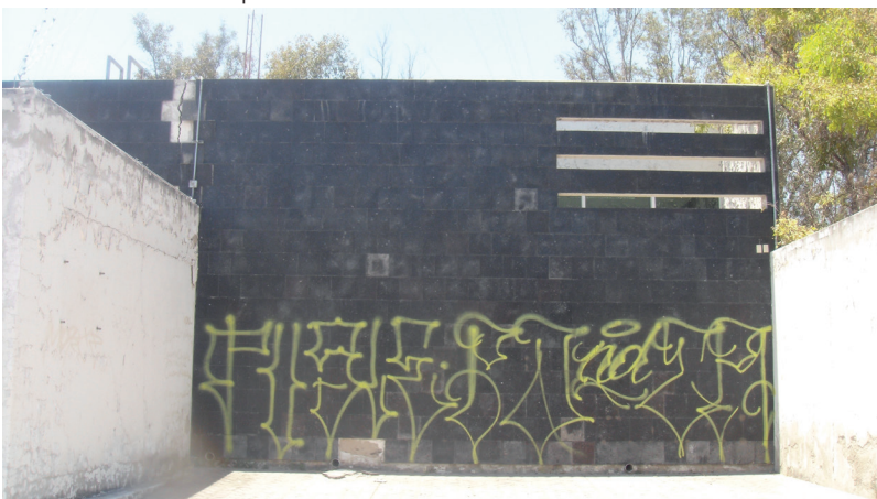
Fuente: Foto tomada por Eduardo Plazola Meza
