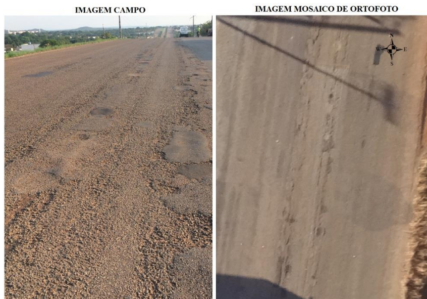
Figura 8. Desgastes superficiais na entrada da cidade de Palmas - TO.
