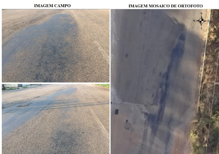
Figura 9. Exsudação em trecho próximo ao bairro Taquaralto.
