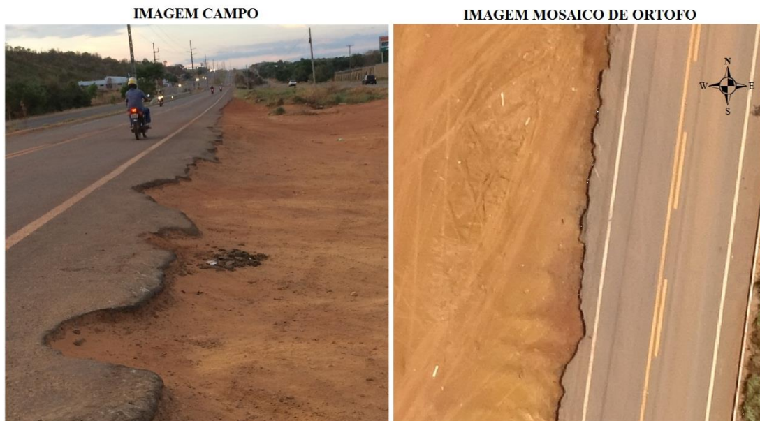
Figura 4. Perda de revestimento do acostamento.
